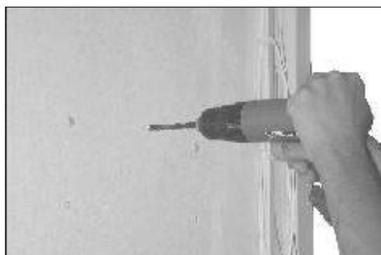
Per prima cosa eseguire i fori al muro per il fissaggio del contenitore della centrale Elisa LTE.
